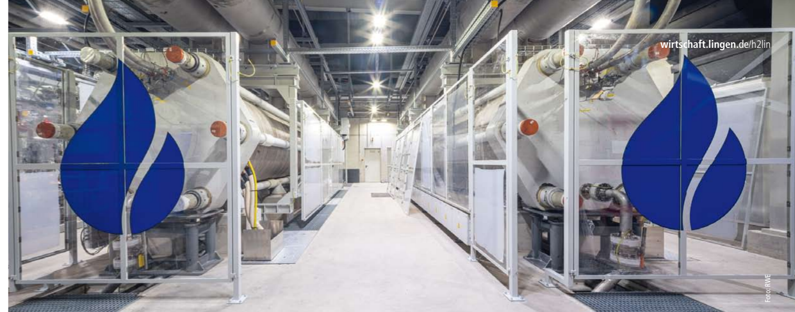
oben: Eine der zwei Teilanlagen – der Alkali-Elektrolyseur von Sunfire mit einer Kapazität von 10 MW unten: Allen Grund zur Freude – gute Stimmung beim Gruppenbild
